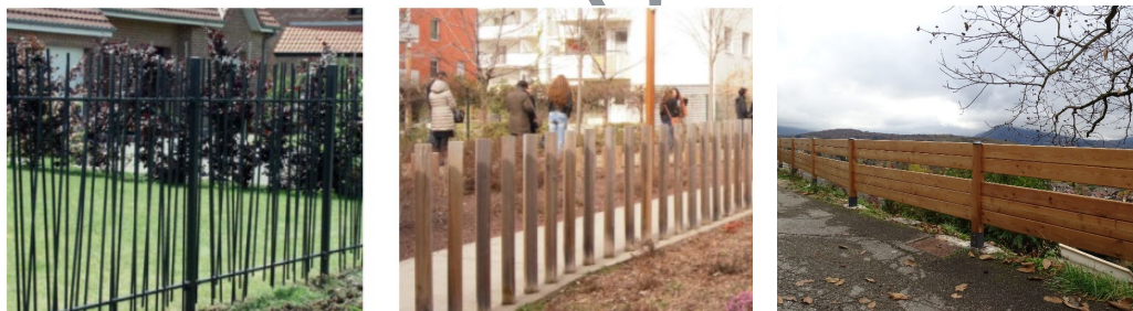
Exemples de clôtures perméables à la faune
